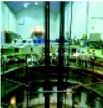
Rehabilitación de estatores en El Caracol .
